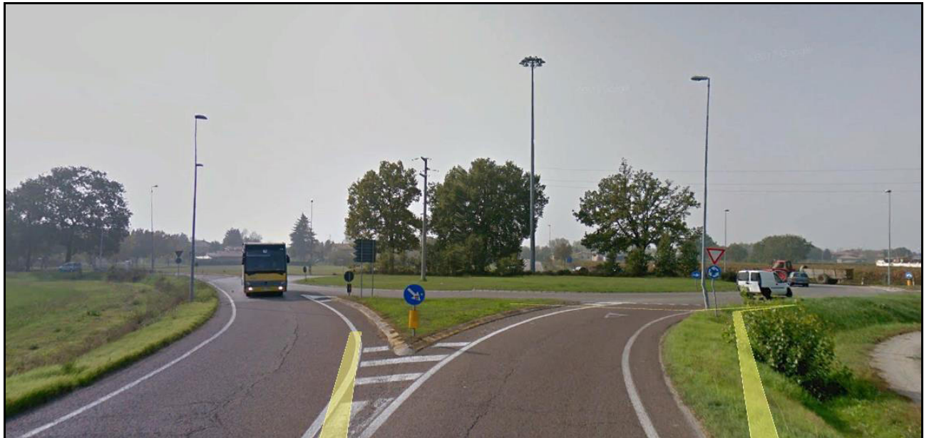
Figura 11 - Intersezione 4 - Incrocio tra la S.P. 52 con via Molinazza, con vista da Nord
