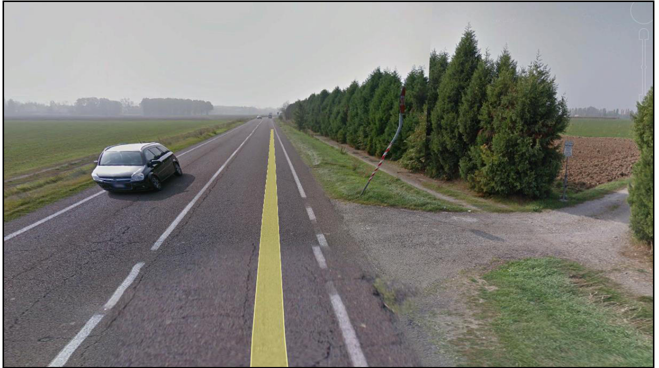
Figura 10 - Intersezione 3 - Incrocio tra la S.P. 52 e via Babilonia, con vista da Nord
