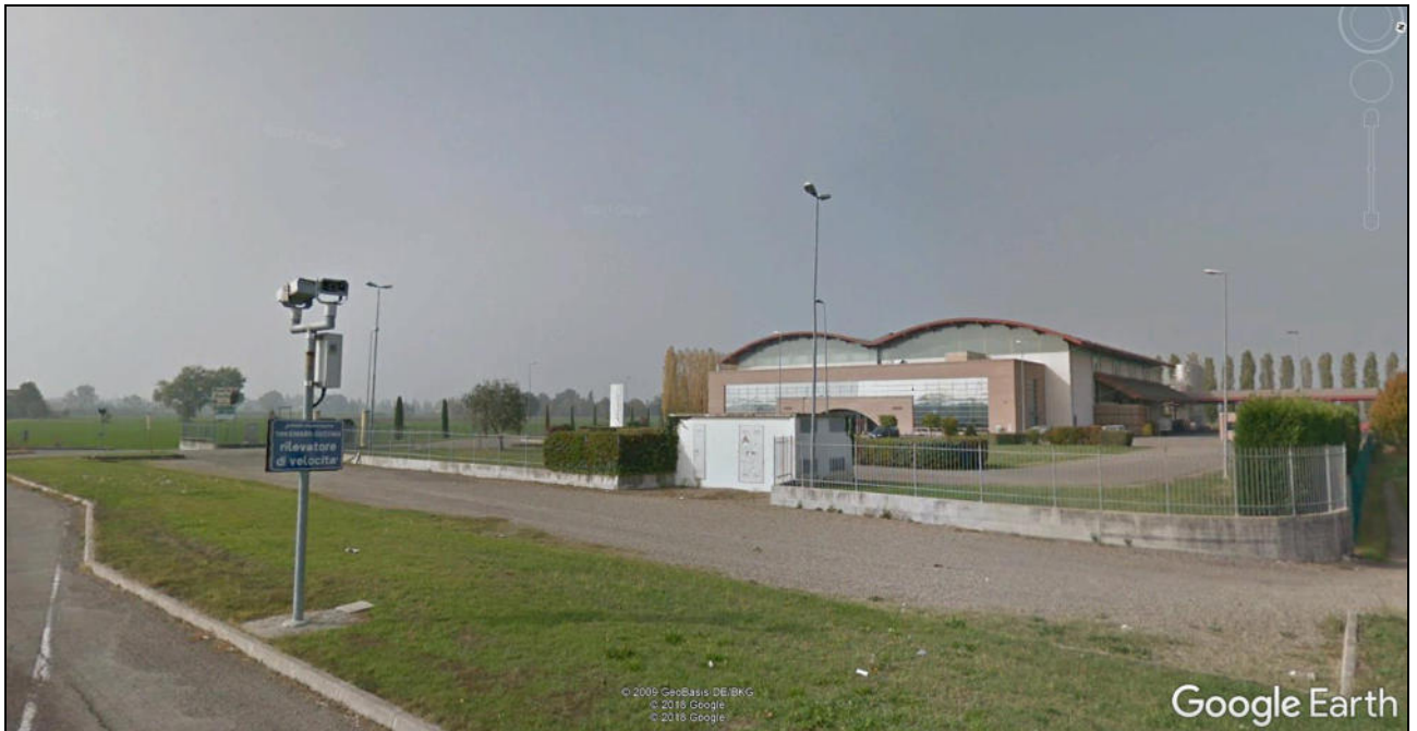
Figura 15 – P3 vista dell'area di Piano da Nord, proseguendo lungo via 11 Settembre 2001 (SP52), in cui è possibile notare l'edificio già esistente (Emilia Wine S.r.l.)
