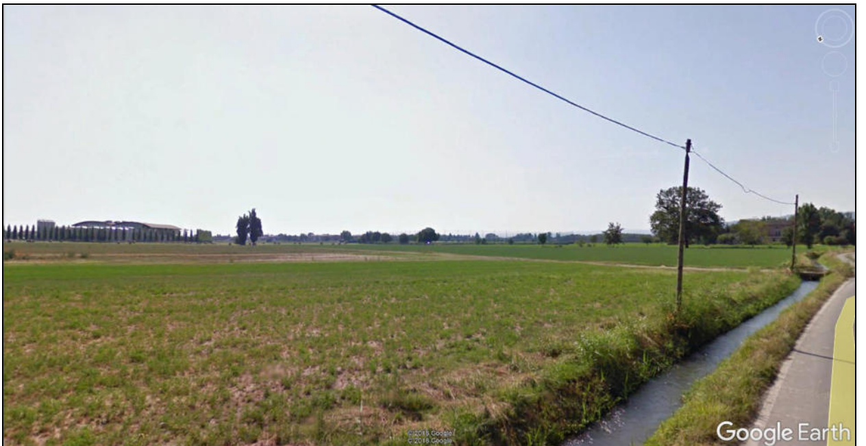
Figura 17 – P4 vista dell'area intervento dal lato Ovest, proseguendo lungo via Partitora
