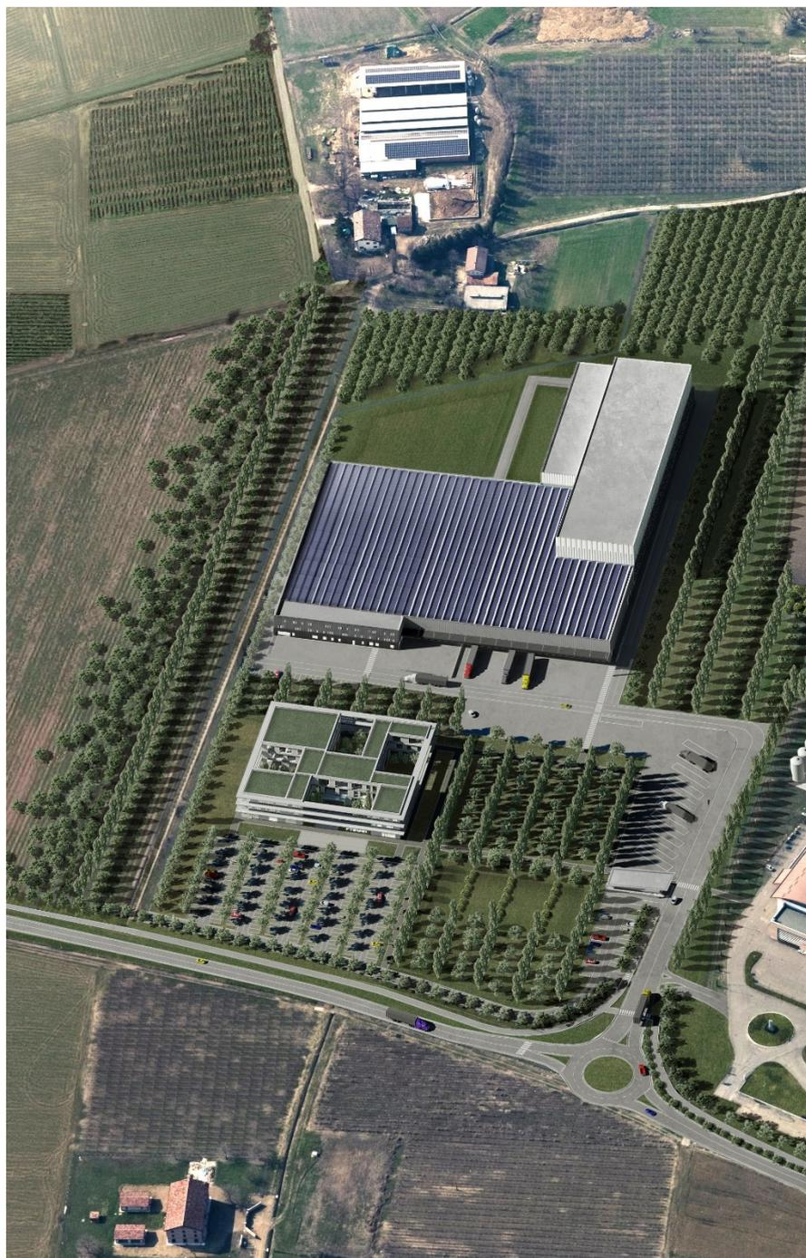
Il fabbricato, nel suo complesso, si compone di tre strutture allineate, fra loro indipendenti e complementari, costituenti un'unica unità funzionale, per una superficie netta edificata di circa 25.000 mq.
