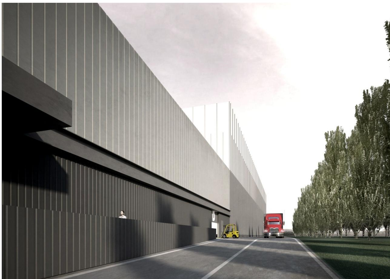
Il magazzino sarà completamente automatizzato (traslo elevatori che transitano su apposite rotaie e in grado di mobilitare in modo automatico i pallet) e non si prevede pertanto l'ordinaria presenza di lavoratori, se non per operazioni di manutenzione o operazioni straordinarie. La struttura sarà rivestita da pannelli leggeri tipo sandwich con struttura metallica a doghe.
