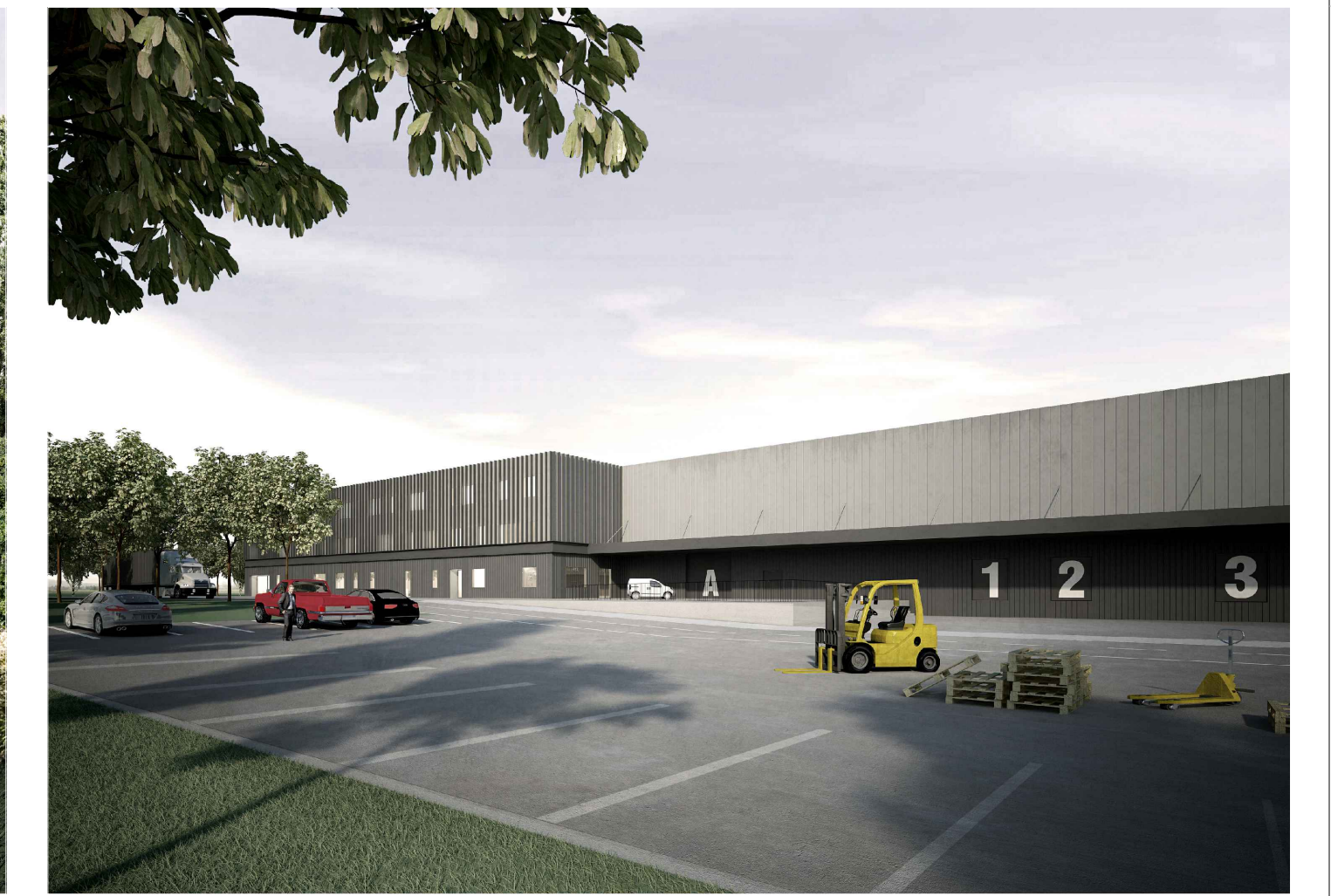
08 - CAPANNONE - VISTA LATO EST
