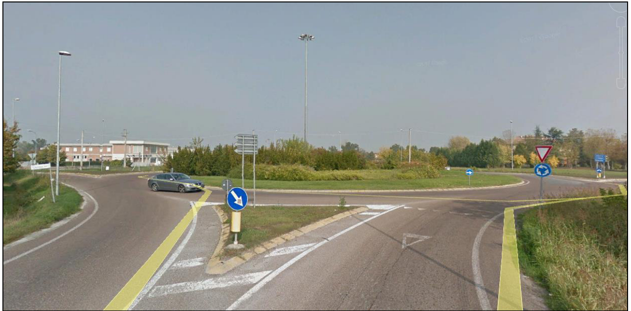
Figura 8 - Intersezione 1 - Incrocio della SP 52 con la SP 66, con vista da Sud.
